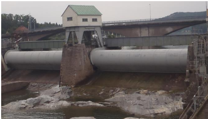
”Medellucka”: idrifttagingsår 1964; 12 m bred; 6,5 m hög; avbördningskapacitet 425 m 3 /s
