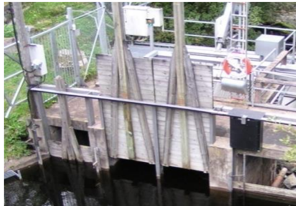
”Medellucka”: idrifttagingsår 1964; 12 m bred; 6,5 m hög; avbördningskapacitet 425 m 3 /s
