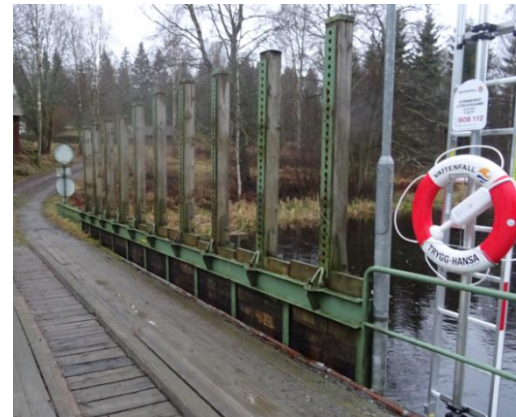
”Medellucka”: idrifttagingsår 1964; 12 m bred; 6,5 m hög; avbördningskapacitet 425 m 3 /s
